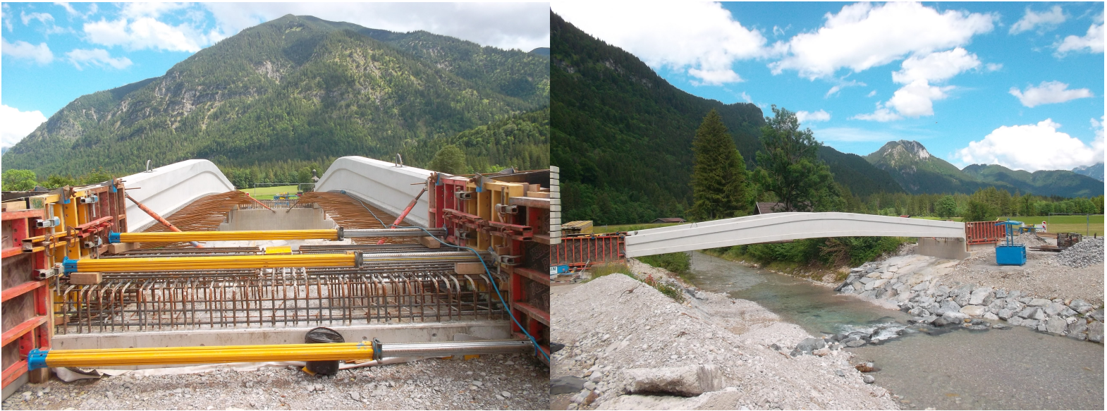
Bau der neuen Brücke
