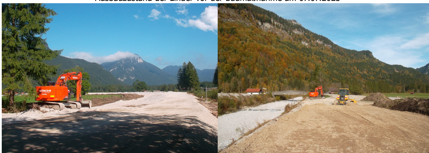
Ertüchtigung und Erhöhung der Dämme
