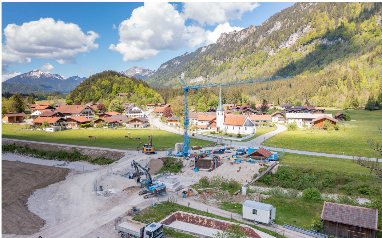
Bau der Fundamente für die neue Brücke
