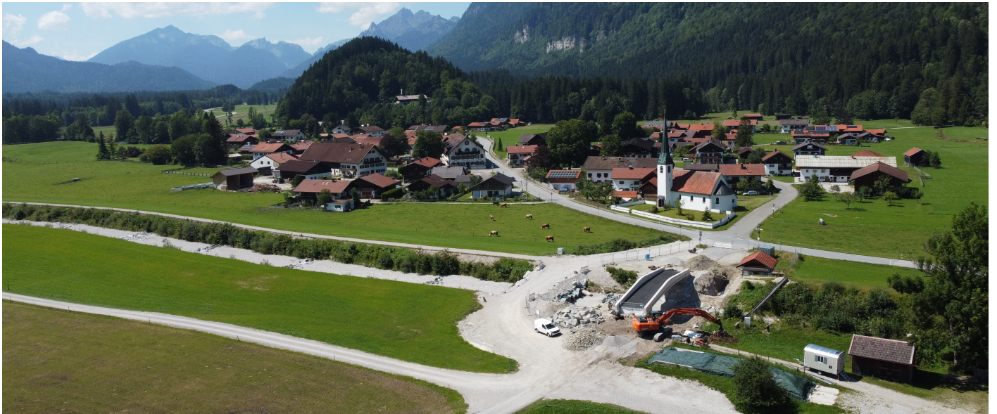
Die neue Brücke ist im Rohbau fertiggestellt 11.08.2024
