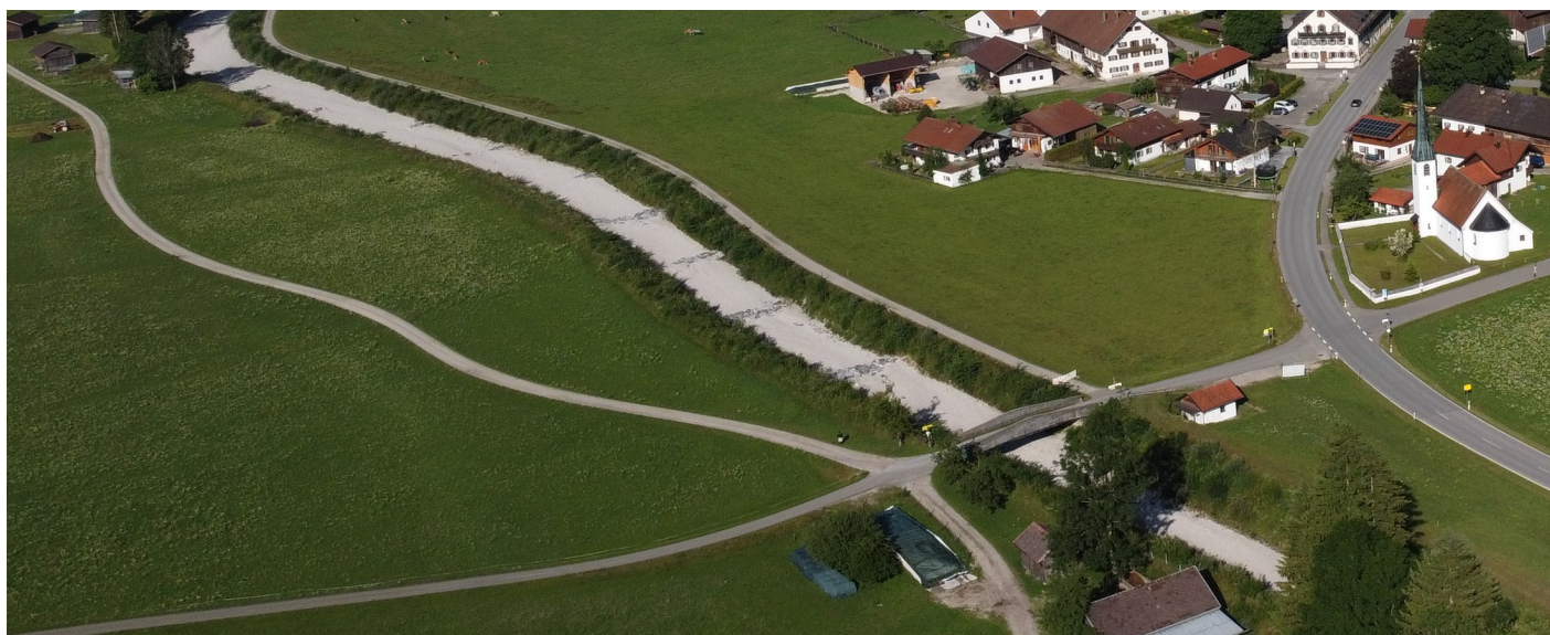
Ausbauzustand der Linder vor der Baumaßnahme am 07.07.2023
