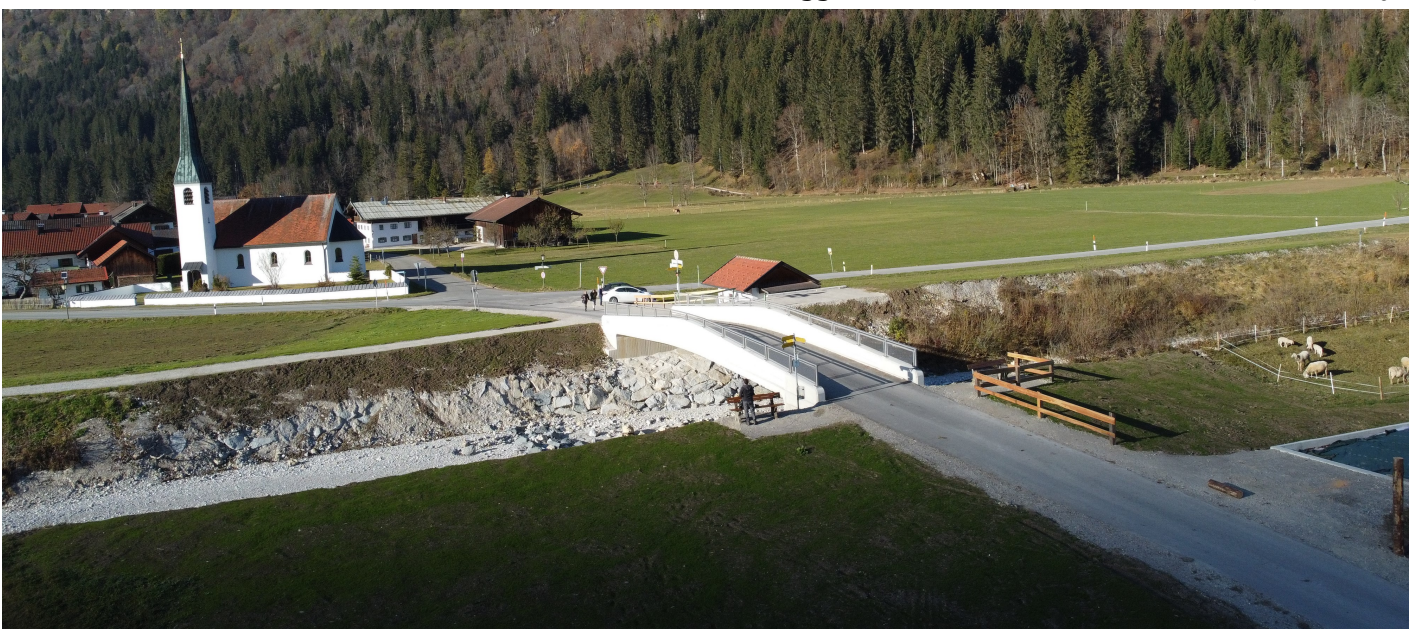
Nach Fertigstellung des Hochwasserschutzes für Graswang 10.11.2024
