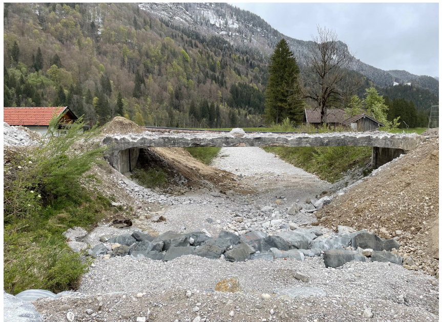
Abbruch der alten Brücke
